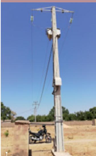
Point de jonction entre le réseau moyenne-tension de Sénélec et le réseau basse-tension exploité par NSRESIF, village de Diaglè.
